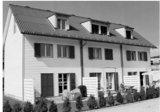
Abb. 1: Südansicht des untersuchten Niedrigenergiehaus
